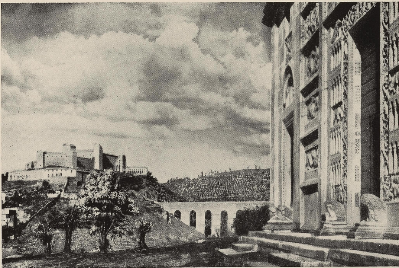
La rocca e il ponte delle torri: in primo piano, la facciata di S. Pietro.
