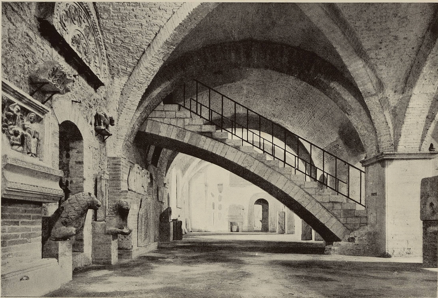
FIG. 31. — Vista dell'interno del primo piano del palazzo della Signoria ora Museo civico. Le due navate lunghe 40 metri hanno una larghezza di metri 5,50 e 4,50. Notare i robusti pilastri in travertino, le volte e i costoloni, che legano l'arco a tutto sesto a quello acuto. La scala di accesso al teatro, ripristinata nel restauro del 1958 è in pietra locale.
