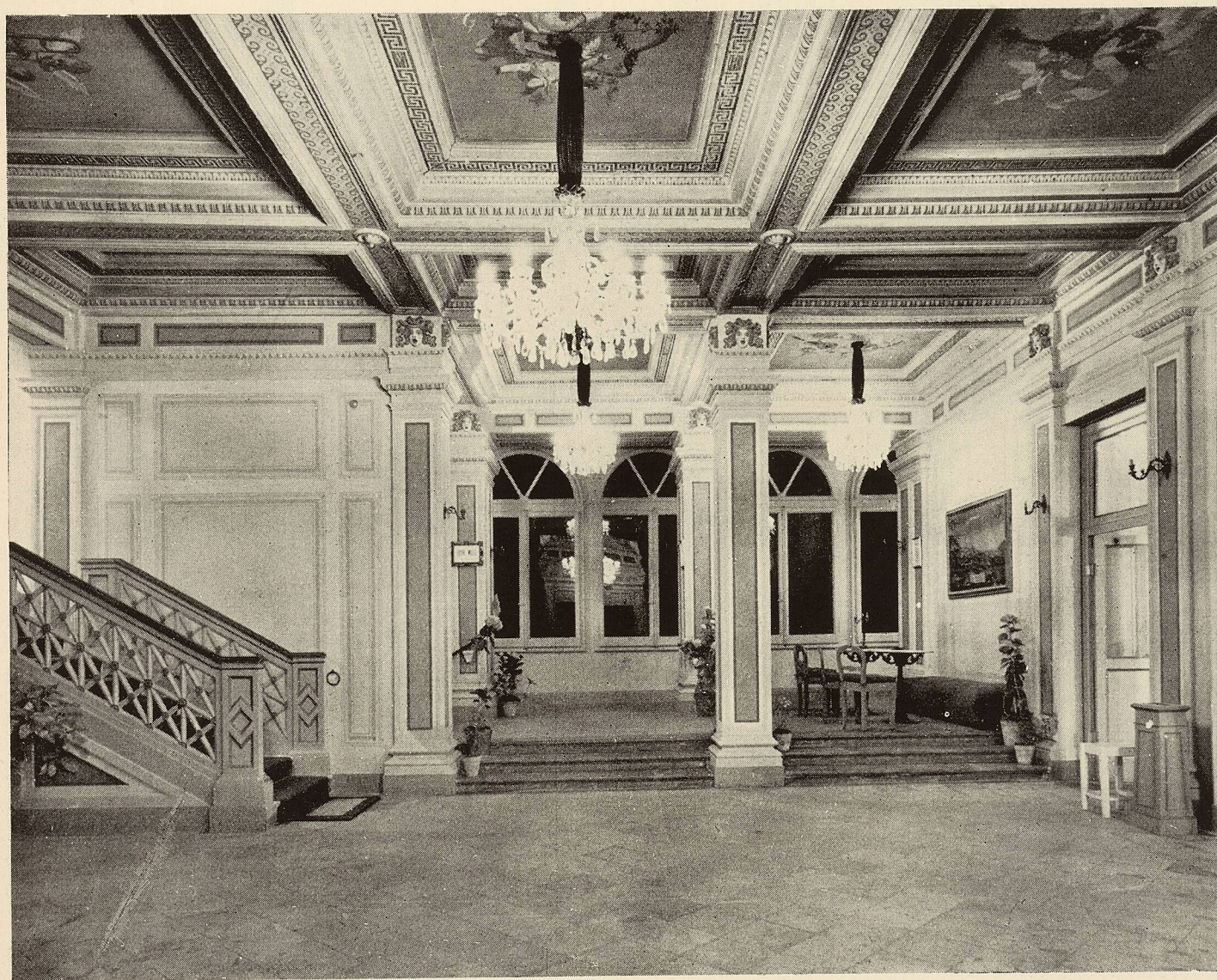
FIG. 12. - Dopo i lavori di restauro del 1958.
