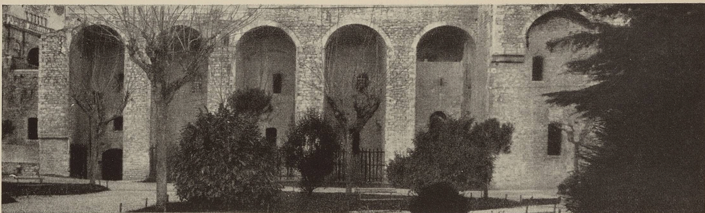
FIG. 3. - Il palazzo della Signoria visto dalla piazza della Signoria. Nell'unica facciata visibile il palazzo presenta il caratteristico aspetto delle costruzioni arcuate degli edifici medievali dell'Umbria. Con torre centrale (a destra) e contrafforti esterni legati da archi; così rimase alla morte del gonfaloniere Pietro Pianciani. Le costruzioni superiori furono aggiunte posteriormente.
