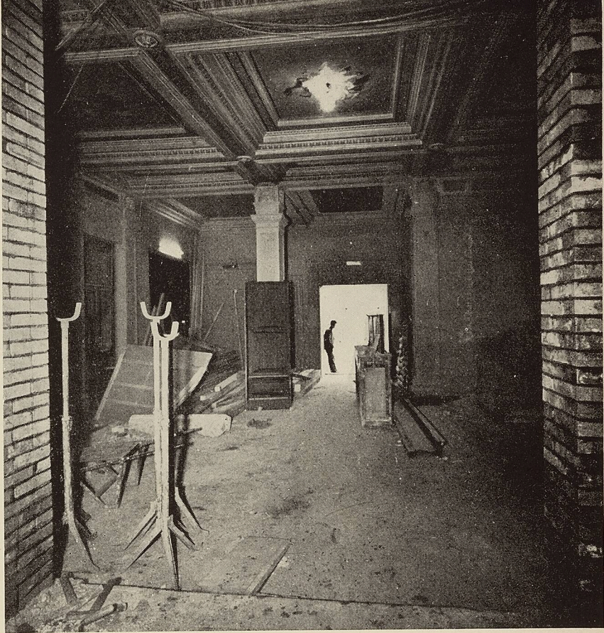
FIG. 23. – Il foyer visto dalla loggia panoramica dopo l'abbattimento del muro divisorio.
