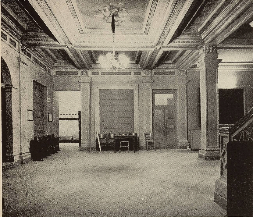
FIG. 20. - Il foyer prima del restauro del 1958.
